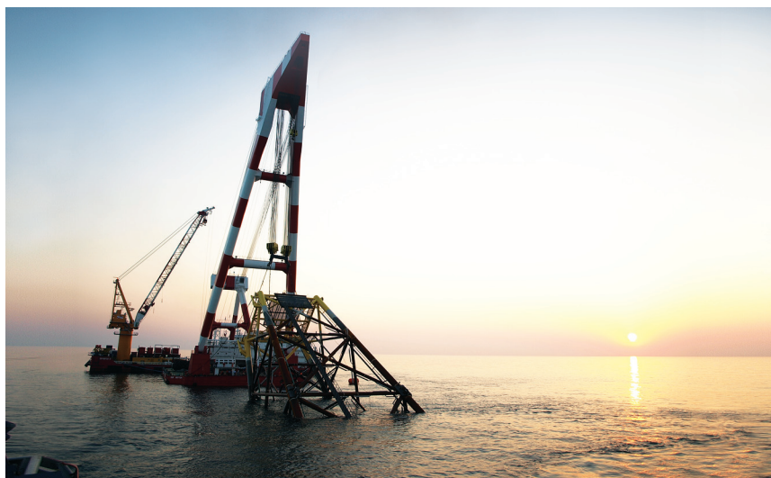
Строительство морской части газопровода
