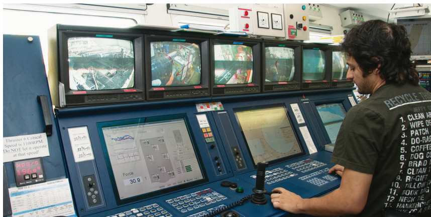
Технологический контроль за укладкой труб
